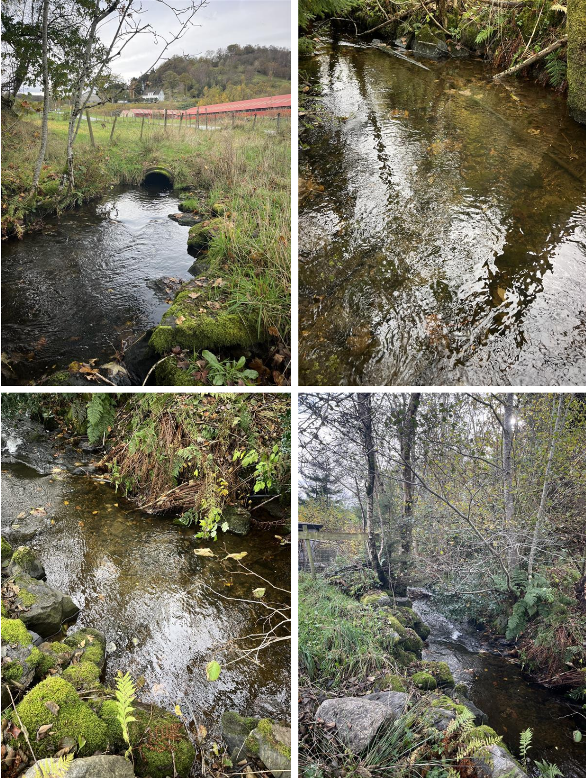
Figur 4: bilder fra befarings. Øverst t.v.: eksisterende stikkrenne. Øverst t.h.: variert bunnsstrat med overvekt av grus og stein. Nederste to bilder: gammel erosjonssikring med steinblokker.
