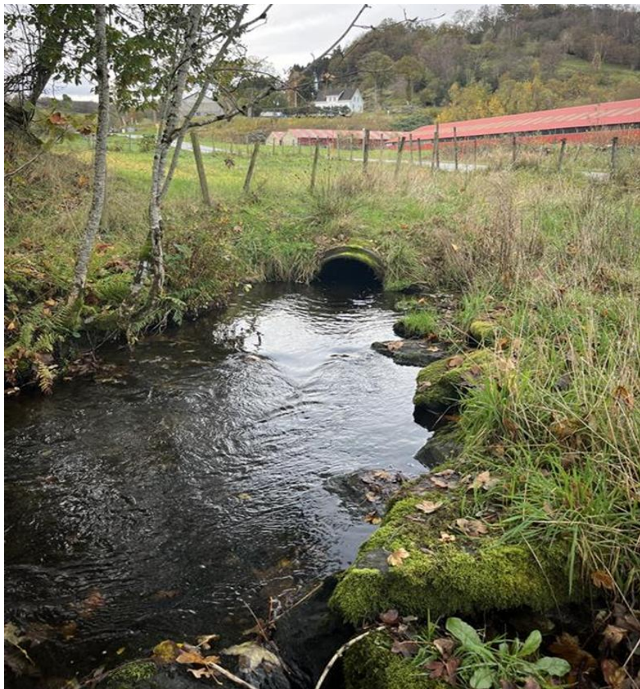
Figur 10: Illustrasjon av hvordan utskifting av stikkrenne vil kunne se ut. Til venstre: Eksisterende betongrør under Finnøyvegen.. Til høyre: eksempelbilde på utforming av tilsvarende bokskulvert som er planlagt.
