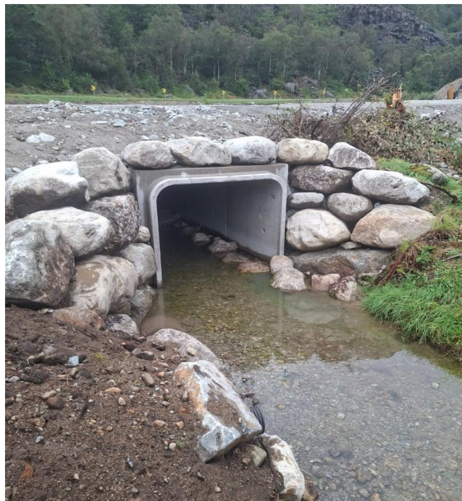
Figur 10: Illustrasjon av hvordan utskifting av stikkrenne vil kunne se ut. Til venstre: Eksisterende betongrør under Finnøyvegen.. Til høyre: eksempelbilde på utforming av tilsvarende bokskulvert som er planlagt.
